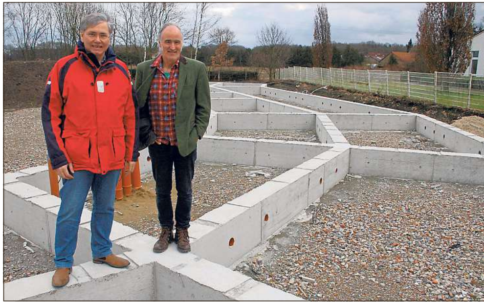
Das Fundament steht, und noch im März wird ganz offiziell der Grundstein gelegt: Dr. Rainer Kossow (l.) und Thomas Grollmus führen über die Baustelle des Kulturquartiers Münster an der Rudolf-Diesel-Straße. Bild: Zinke
